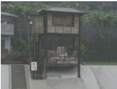
岸邊 2 層樓高觀景台
