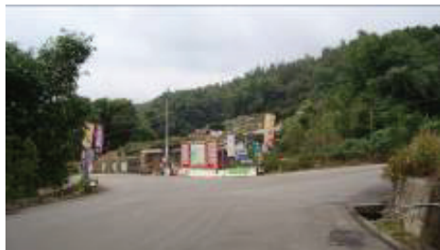
暨大後門路口缺少道路安全設施
