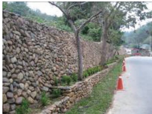
民國 98 年度水土保持局補助經費，桃米社區工班自行設計施工的砌石擋土牆，結合社區生態特色-蜻蛉-相當美觀
