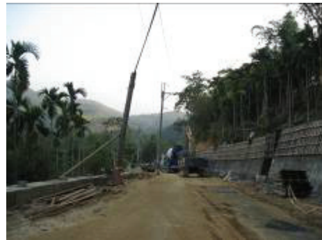
水上巷 1K 後道路現正拓寬工程
