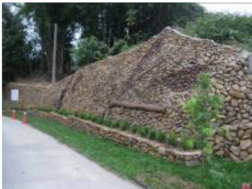
民國 98 年度水土保持局補助經費，桃米社區工班自行設計施工的砌石擋土牆，結合社區生態特色-蜻蛉-相當美觀
