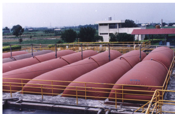
覆皮式厭氣發酵槽
