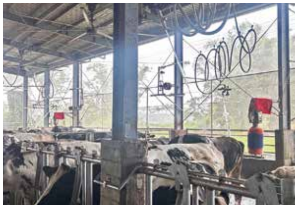
▲ 圖二、高壓自動沖洗裝置可以定時進行牛舍的沖洗，糞尿會馬上排入排水孔。
