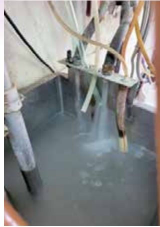
▲確認清洗水量及酸鹼PH值。 ▲量測出水溫度。
