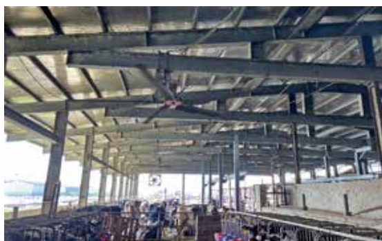
▲部分畜舍已開始更換為變頻式電扇，節省電力成本。
