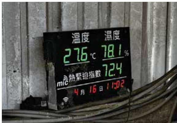
▲圖二、畜舍中設有溫溼度監測系統，可即時知道畜舍內的環境狀況。
