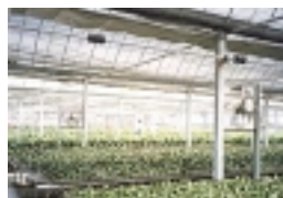
苗株栽培設施增加風扇，促進內循環通風 (三傑蘭園)
