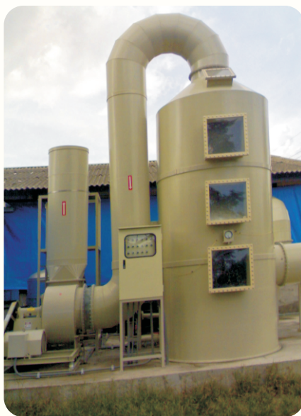
圖2-2-10 堆肥場生物滴濾法除臭裝置。
