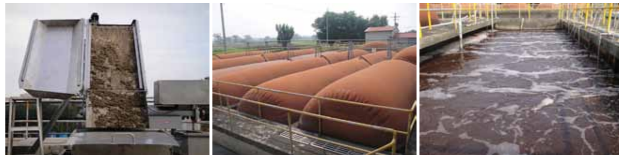
固液分離 厭氣發酵 活性污泥處理
