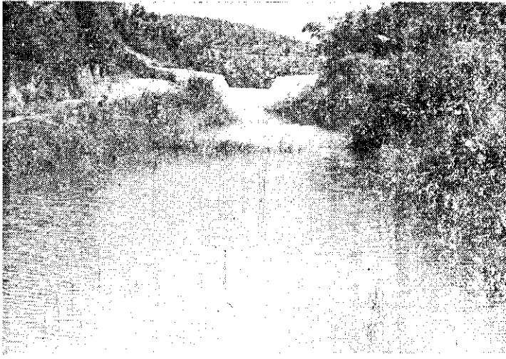
池水欄的成築溝水然天用利：三圖
