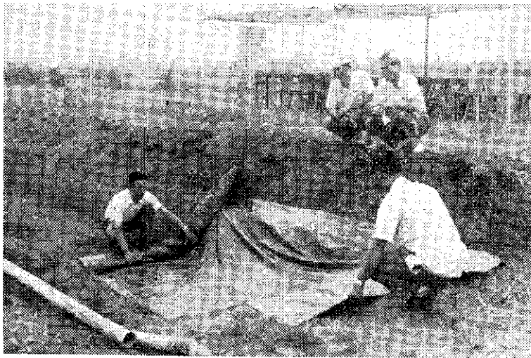
砂地鋪敷柏油膠布防漏
