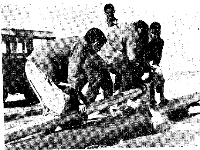
利比亞工程師將地下水引入灌溉管內
