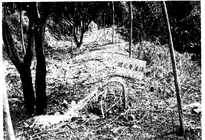
—固定注管灌法—
