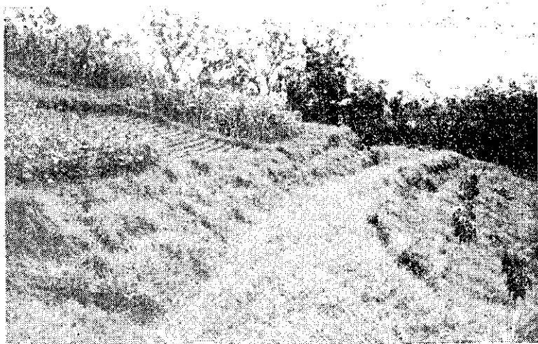
——山邊溝及上、下邊溝種植百喜草，穩定坡面及溝面——
