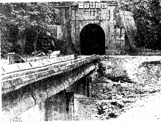
北迴鐵路的小清水隧道即將完工(中央社)
