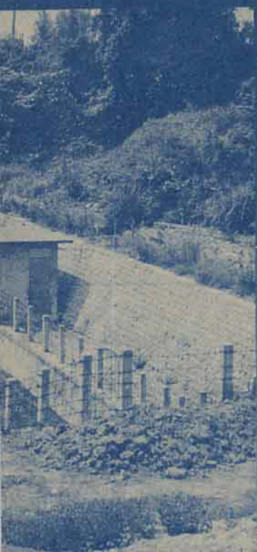
石岡壩南幹線水路
