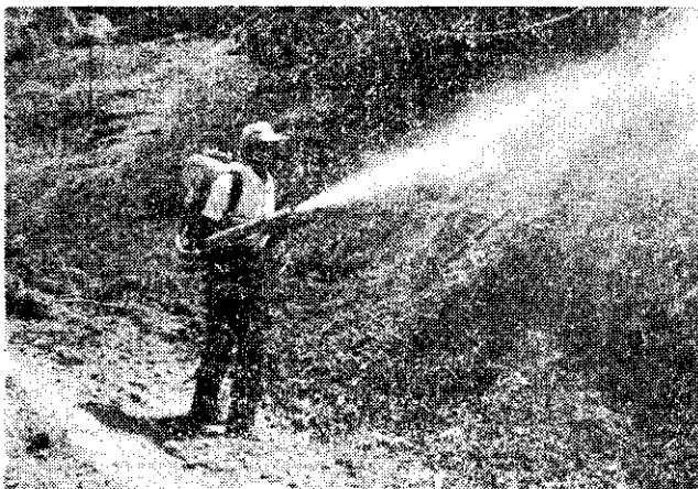
小型噴植機噴植施工情形
