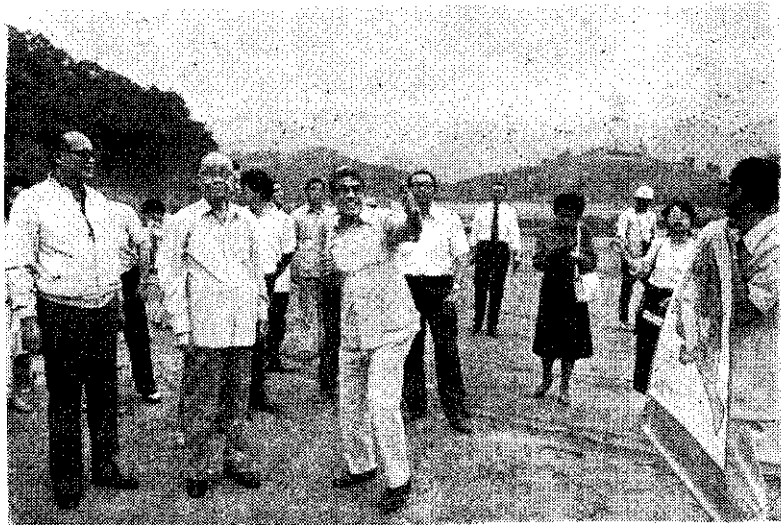
謝副總統參觀新建中的台北動物園，園長王光平說明施工情形。(中央社)
