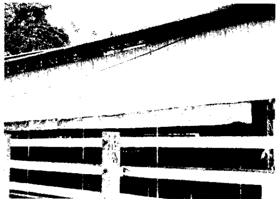
牛舍西側水泥浪板內再加防熱氈，防熱效果更好。
