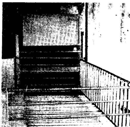
圖1 冲水箱系統，包括冲水箱、條狀床，及床下的水溝。
