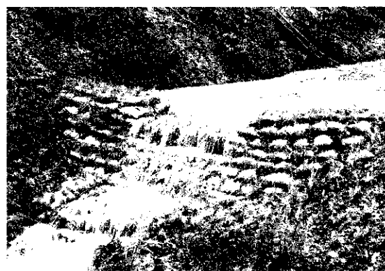
大型砂溝處理：工袋壟 穩定蝕溝，極為經濟有效。
