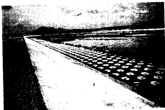
二重疏洪道堤防
