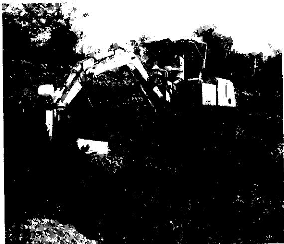
圖2 小型挖土機，整地和深耕作業情形。
