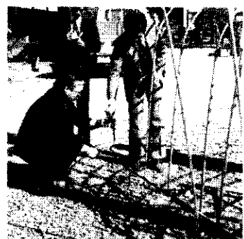
羅旋樁 加強溫室鐵架之固着力
