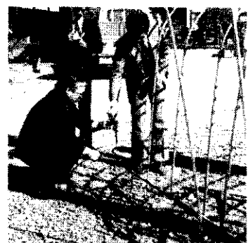
羅旋樁 加強溫室鐵架之固着力
