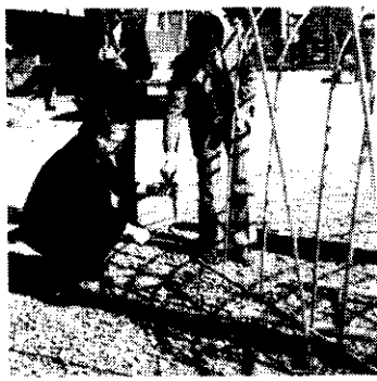
羅旋椿 加強溫室鐵架之固着力
