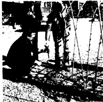
羅旋樁 加強溫室鐵架之固着力
