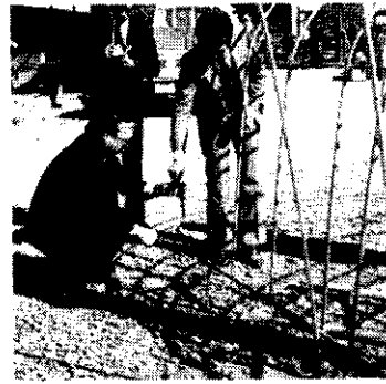
羅旋樁 加強溫室鐵架之固着力
