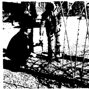
羅旋椿 加強溫室鐵架之固着力
