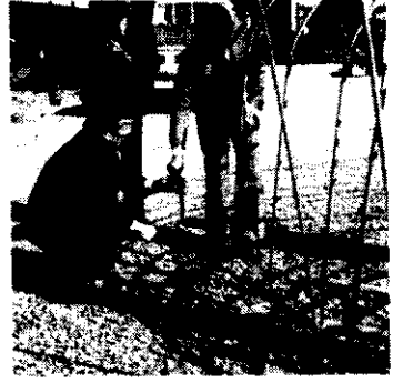
羅旋樁 加強溫室鐵架之固着力
