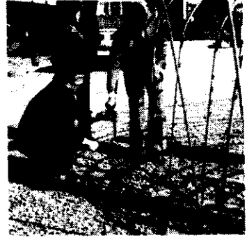
羅旋樁 加強溫室鐵架之固着力
