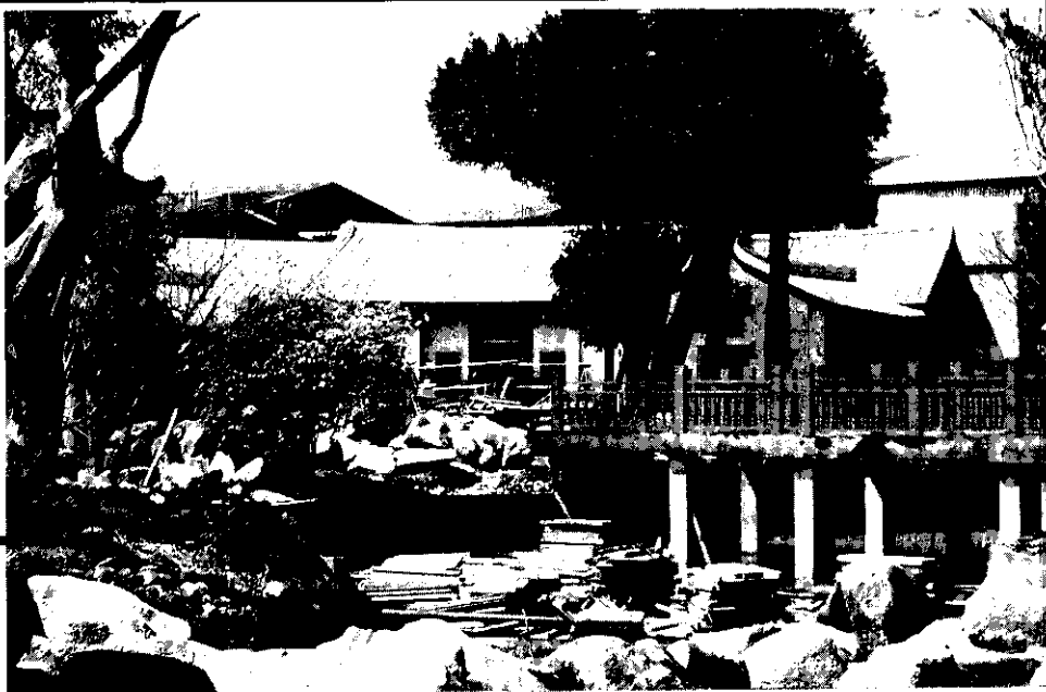
施工中的板橋農村公園（黃兆鴻攝）
