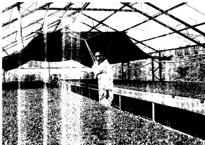
屋頂加蓋可拉式遮光網，夏天可降低室溫。
