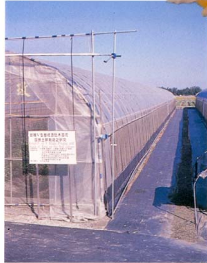
圖8. 利用捲陽器可以調節溫度及濕度。遇有寒流或颱風來襲時捲下可以減少災害之發生，並且可以行密閉式薰蒸藥劑。
