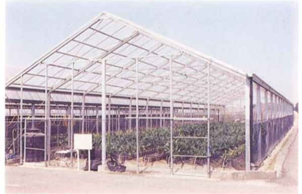
圖2. 較高的設施較不易發生熱累積，而影響作物之生育。
