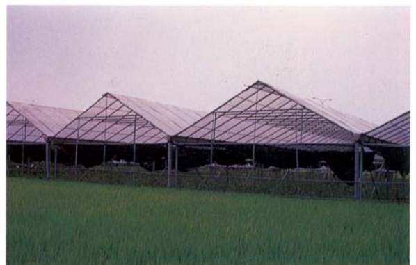
圖4. A字型連棟溫室，屋頂較高，不易熱累積。
