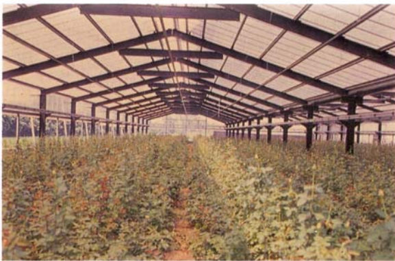
圖3. 鋼骨結構的設施較耐颱風、豪雨，但設施成本較高。
