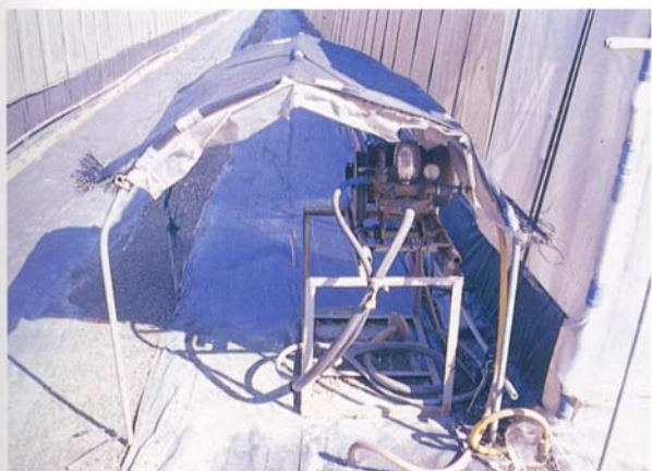
圖3. 噴灑液滴要能細緻均勻，避免沈澱，阻塞噴頭，並注意器械之清潔及維護。
