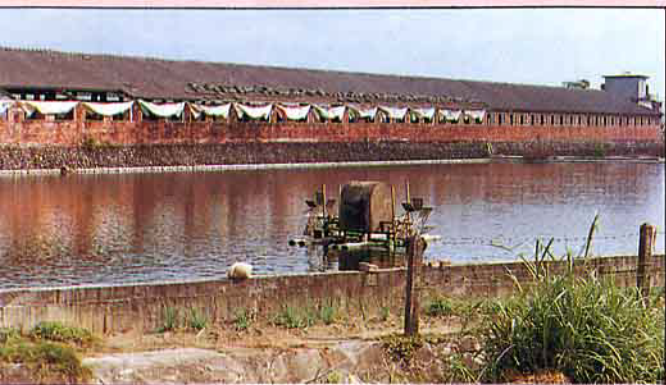
整排的豬舍，排出的豬糞尿採用廢水設施處理。
