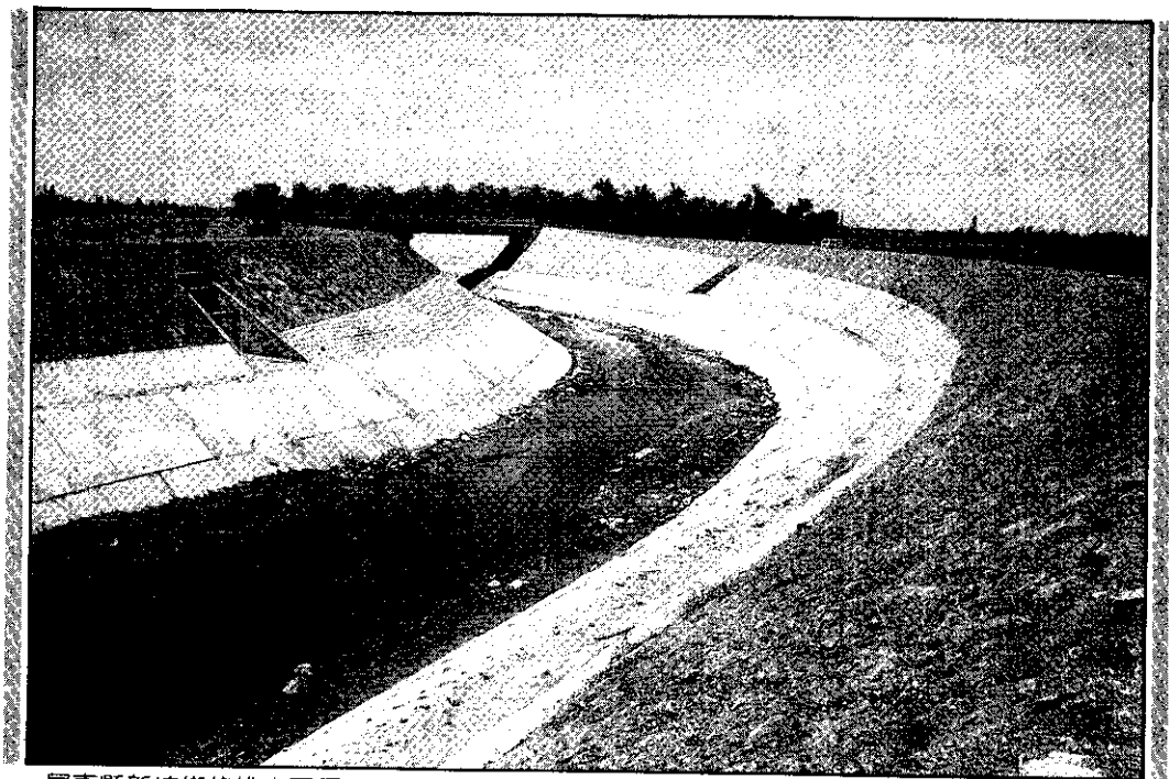
屏東縣新埤鄉的排水工程
