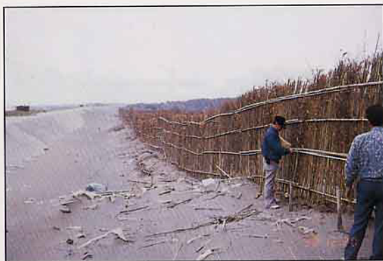
80年度新設防風籬完工檢驗情形
