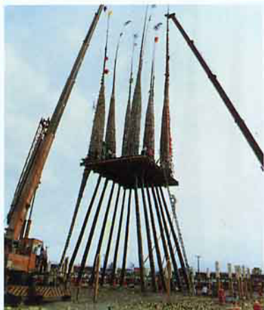
二部吊車吊孤棧
