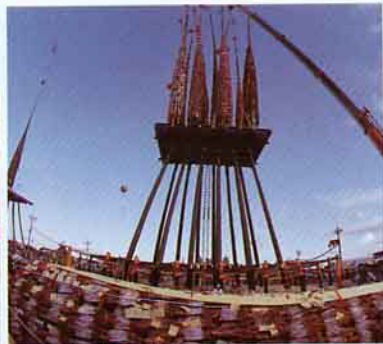
巨型吊車吊孤棧之全景
