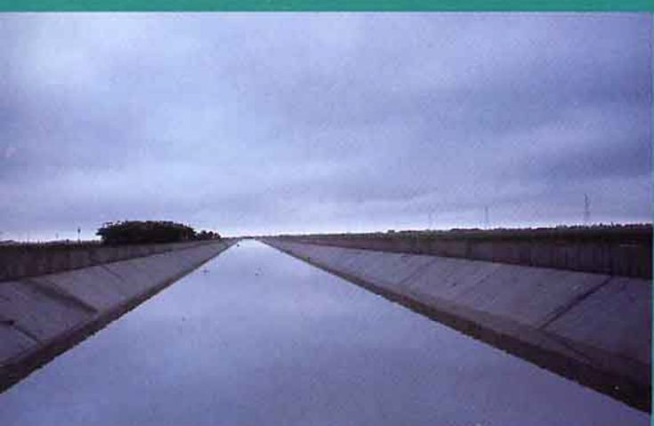
排水系統改善設計標準，因土地利用改變及經濟發展需要提高。排水土堤加強加高工程之一
