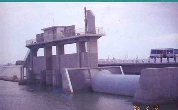
現代化農田水利設施所需投資大、效益高，希望社會大眾共同支持及維護。(制水閘門及橡皮壩)
