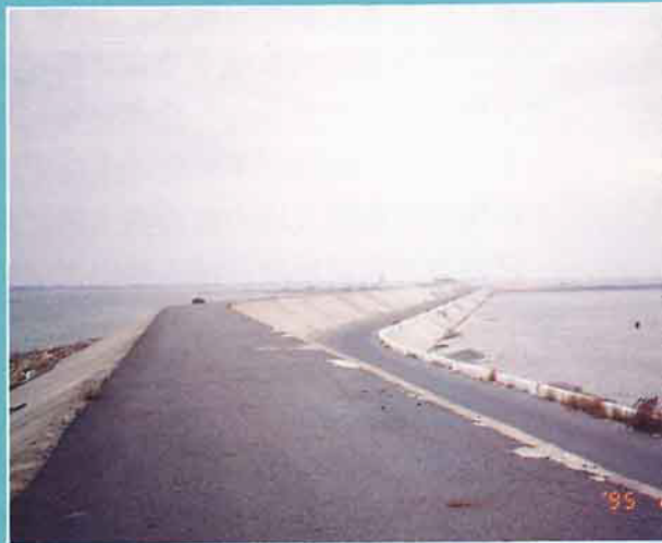
整建河堤，保護沿海居民生命財產，確保海岸地帶之土地利用
