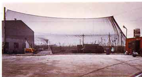
堆肥場周圍設有高架細目防塵網
