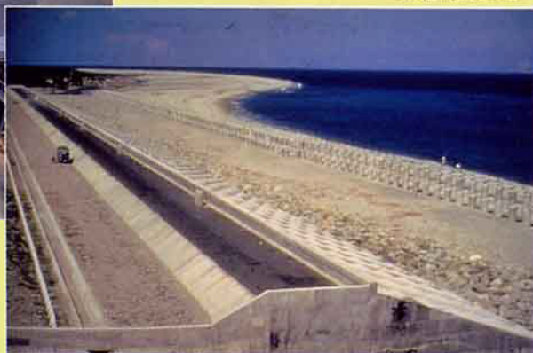
彰化海堤工程。
