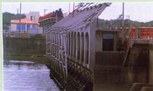
配重式防潮閘門
