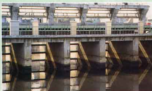
四汴頭抽水站
