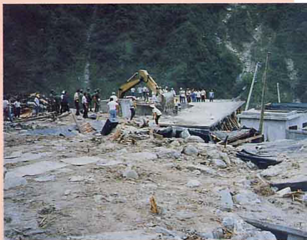
土石流掩埋房舍
