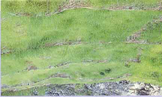
在坡度緩的土質邊坡，用直播法植生之植物生長。
