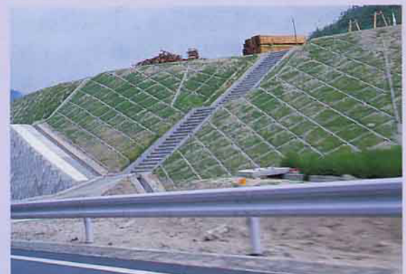
坡面土質差或不穩定處，用框法固定客土後，植生之效果佳。
