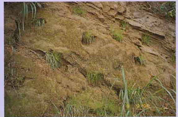
陡削砂岩除用噴植法外，亦可用岩面穴植法植生。
