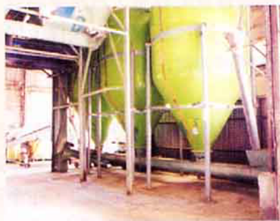
清潔明亮的作業現場
