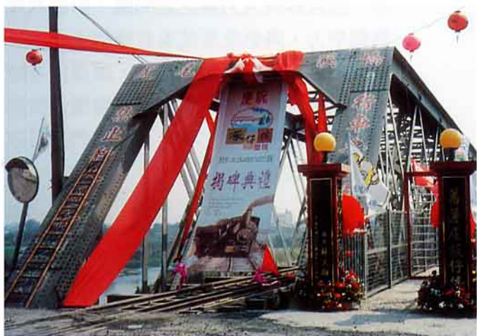
鐵道便橋重生，解決「過不了虎尾溪」之困境
