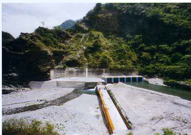
圳路沈砂設備，防止泥砂進入水路，改善灌溉水質
