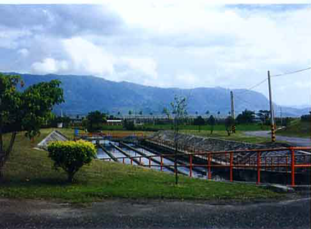
取水、引水設施供應農業用水
