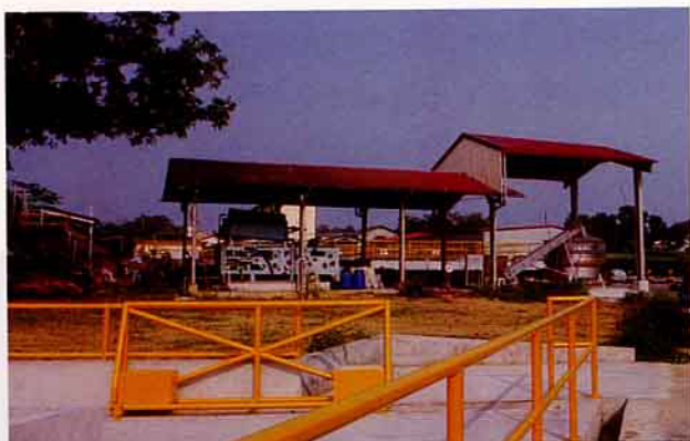
在畜試所架設的廚餘處理場全景
